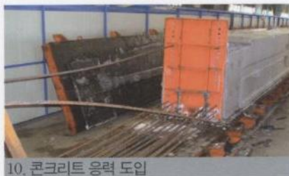
10. 콘크리트 응력 도입
