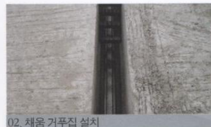
02. 채움 거푸집 설치
